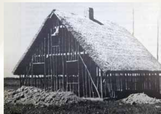
Das Bild aus der Hinrichsfehner Chronik zeigt den Rohbau eines Lehmhauses kurz vor dem Verputzen mit Lehm.
